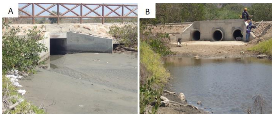
Figura 5-13. Canales que se conectan con la playa de Puerto Velero. Fotos: Cristian Ruiz.
